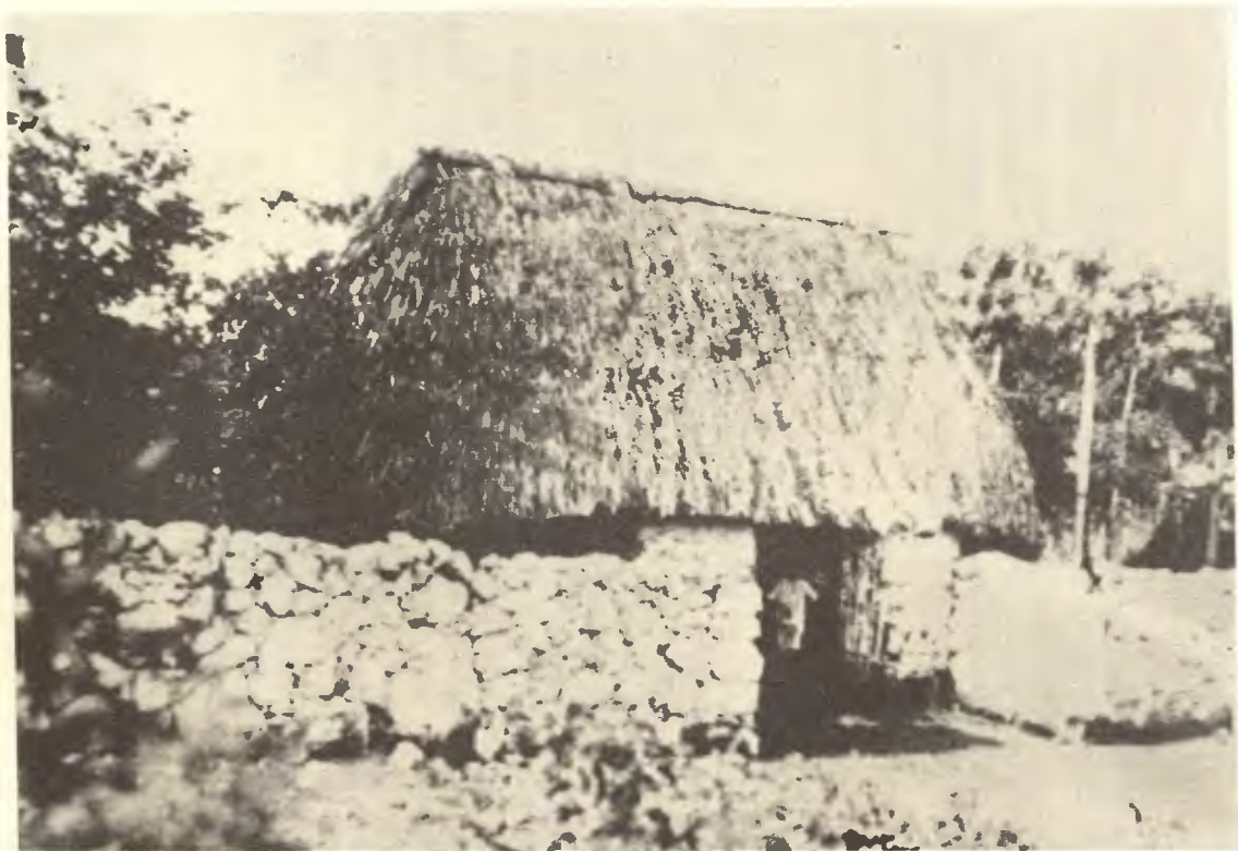
Foto 16. Casa de bajareque y albarrada que delimita el solar (tomada de Redfield y Villa Rojas 1934).
