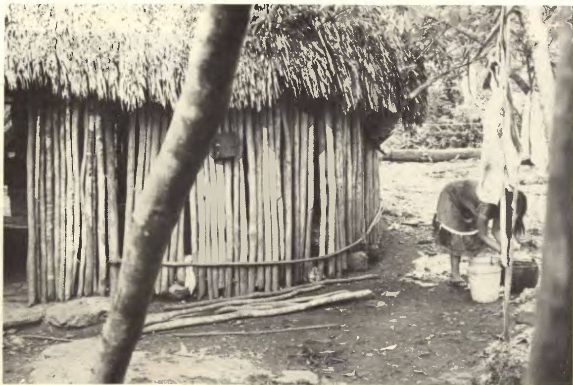
Foto 28. Construcción de bajareque en la unidad moderna estudiada en Cobá.
